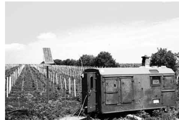
Foto. Captatoare solare pentru producerea energiei electrice (Comrat).
