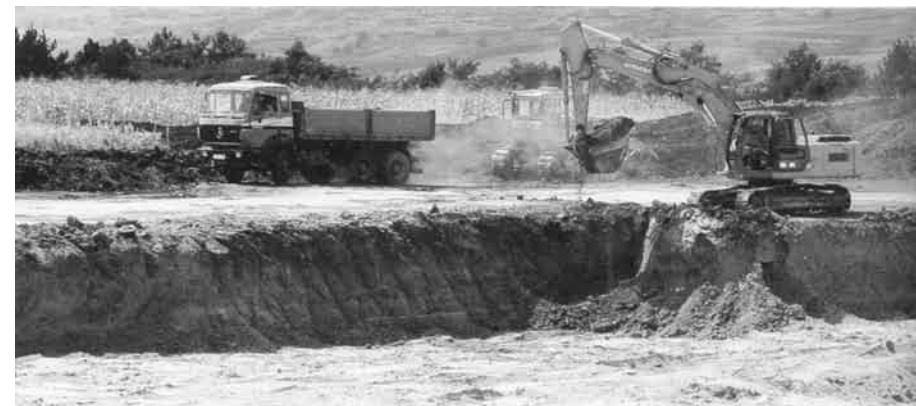
Cariera de nisipuri pentru construcții de Răculești (r-l Criuleni).
